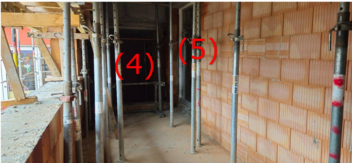
Neuer Zugang zum Speisesaal (4)
