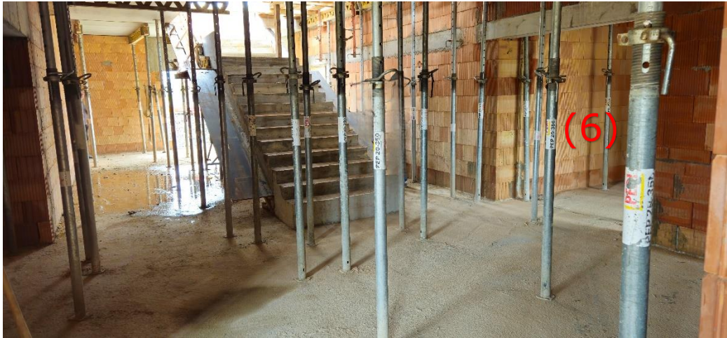
Foyer und Zugang zum 2. Stock der Neuen Einrichtung Zum Haupteingang und zum Fahrstuhl (6)
