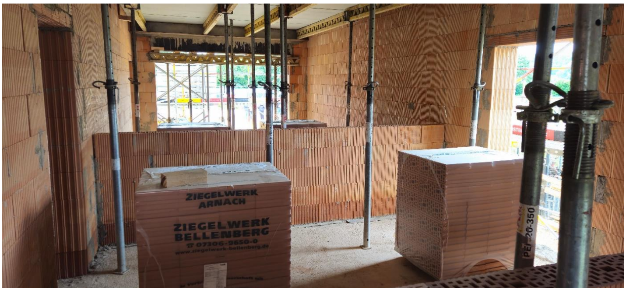
Nebenraum und Sanitärraum des Gruppenraums im EG
